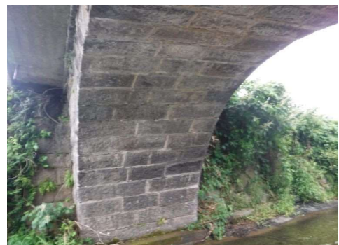
写真-2.4 目地（処理有り）
