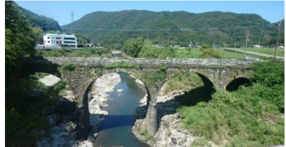
写真-2.2 橋脚を有する多径間の事例
