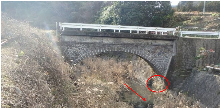
①側面(下流側)
