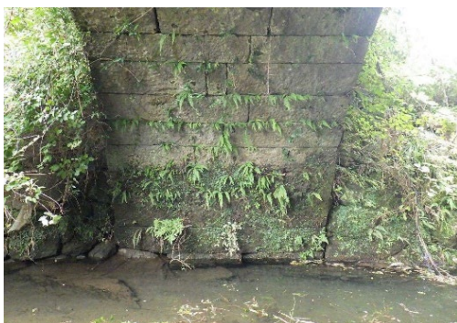
写真-2.5 目地（無処理）
