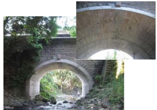
写真-2.7 輪石全体を補強している事例
