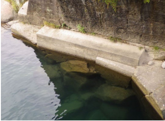
写真-2.6 基礎部分を補強している事例
