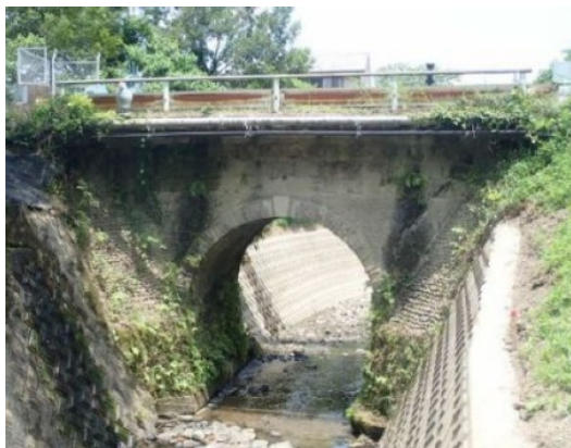
写真-2.8 石造アーチ橋の上部にコンクリート床版を設置している事例
