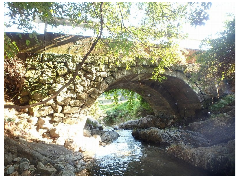
写真3.1-2 古殿橋(豊後大野市)[1817年竣工]
