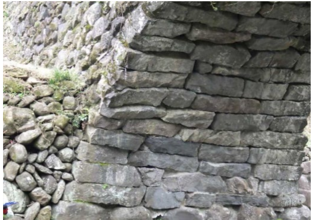
写真3.2-2 自然石を積み上げた事例
