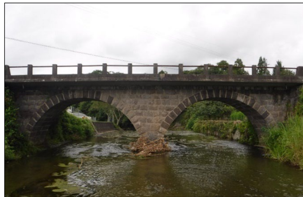
写真1.2-1 石造アーチ橋の事例 [久保橋(臼杵市)]
