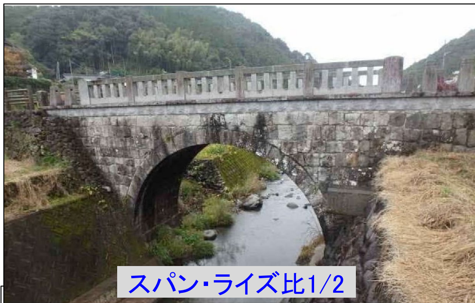
写真2.4-1 瀬戸橋(芦北町)
