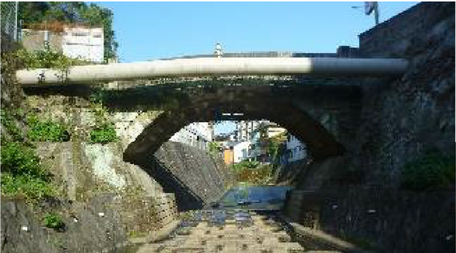
第2位 一の瀬橋(長崎市)
