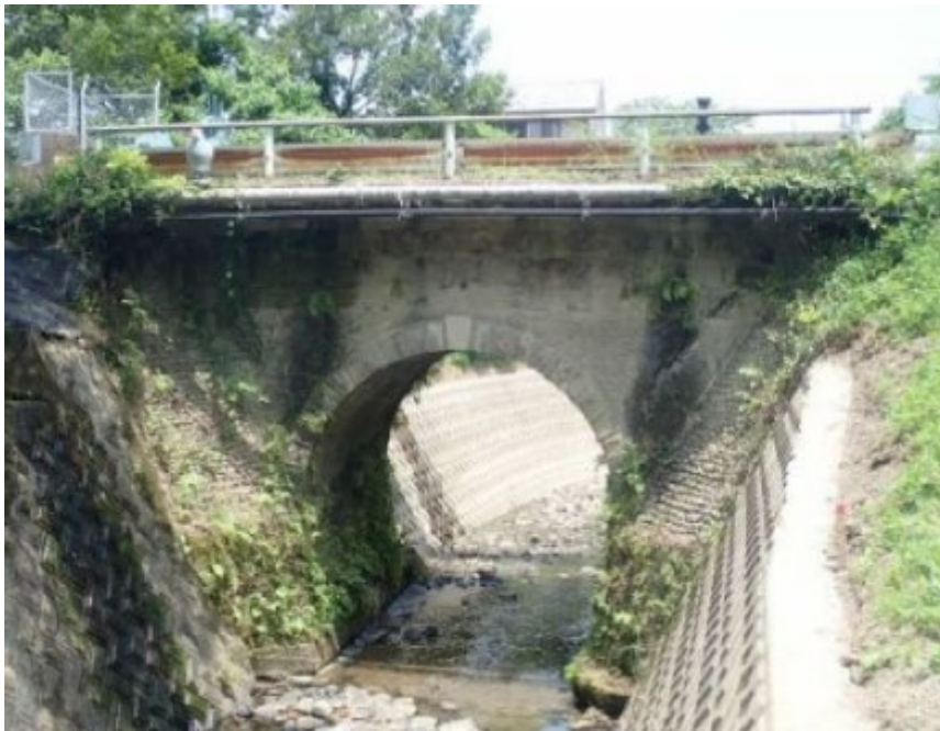
写真3.6-1 コンクリート床版で拡幅している事例
