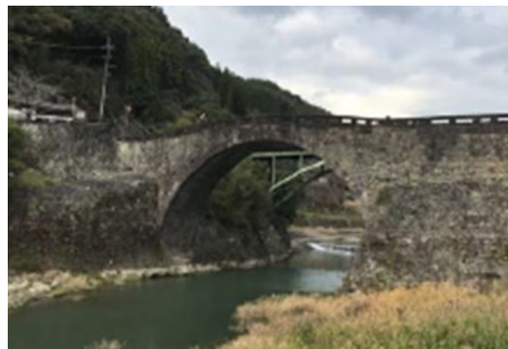
〔国指定〕 霊台橋(美里町)
