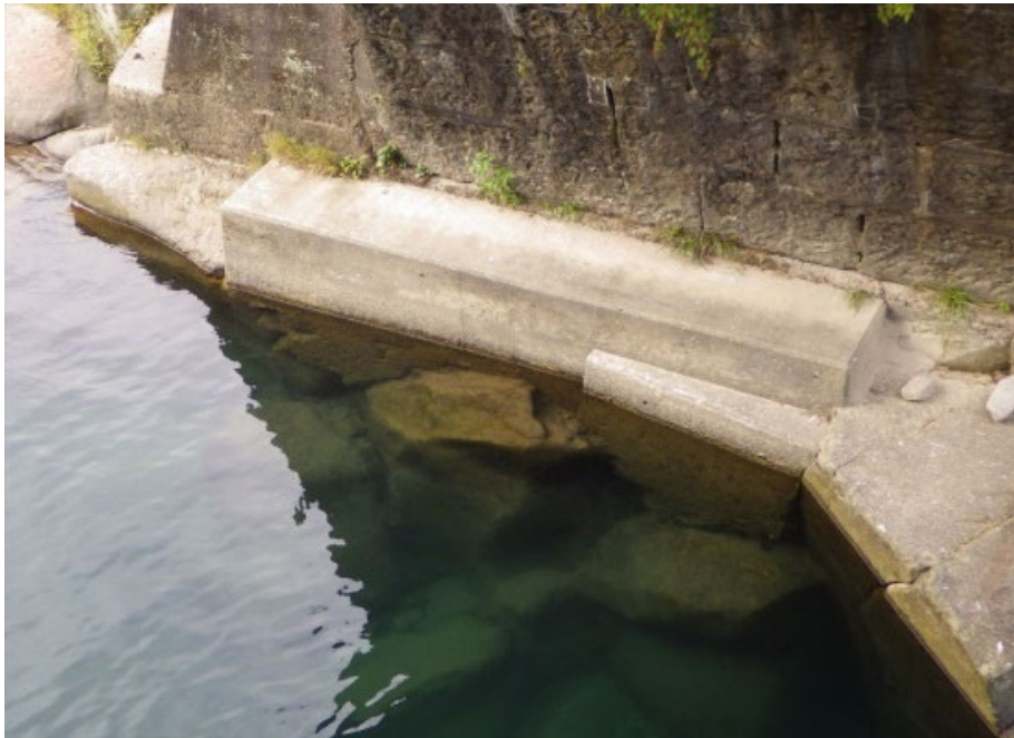
写真3.5-1 基礎部分を補強している事例
