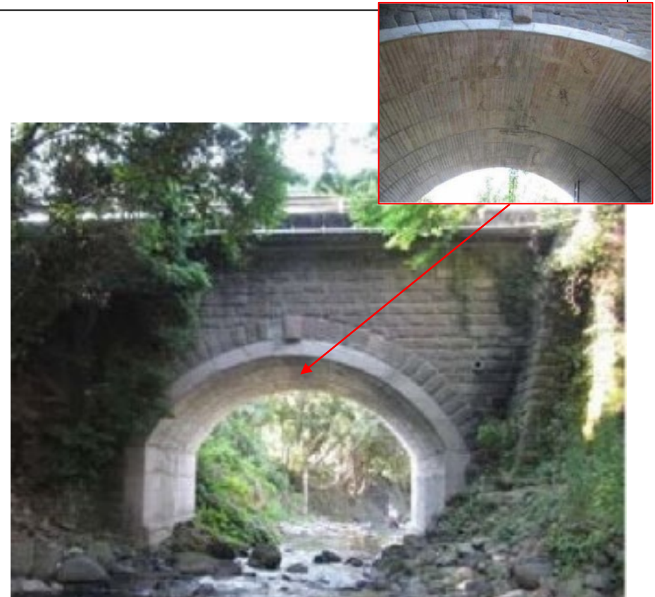
写真3.5-2 輪石全体を補強している事例
