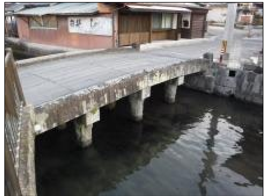
写真1.2-2 石桁橋の事例 [中の橋(佐賀市)]
