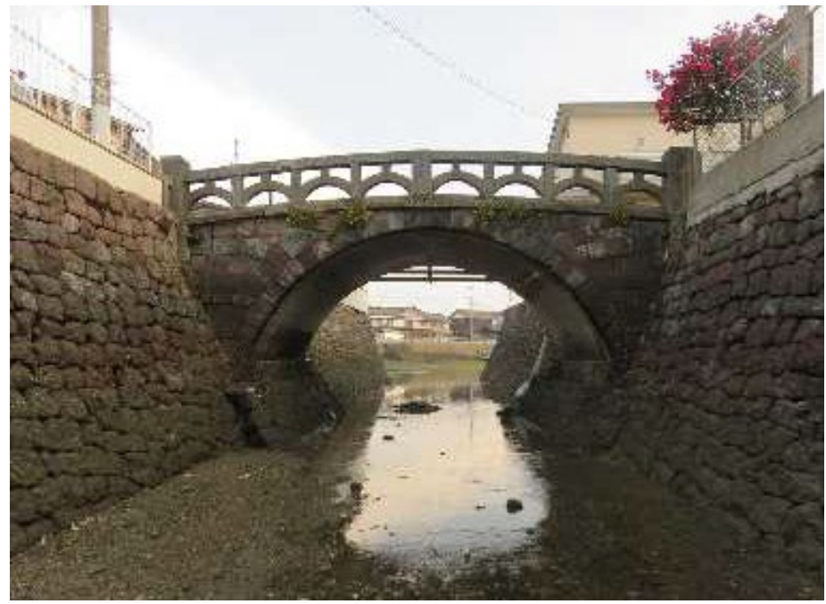
写真1.7-1 護岸勾配に合わせて壁石を構築している事例 [新地橋(島原市)]
