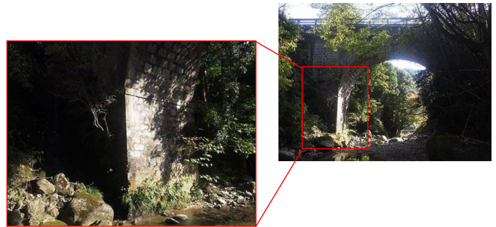
写真1.5-2 橋台を有する単径間の事例
