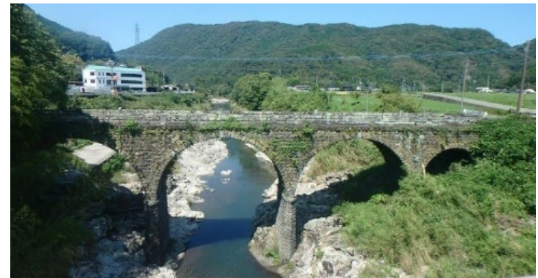
写真1.5-4 高い橋脚を有する多径間の事例
