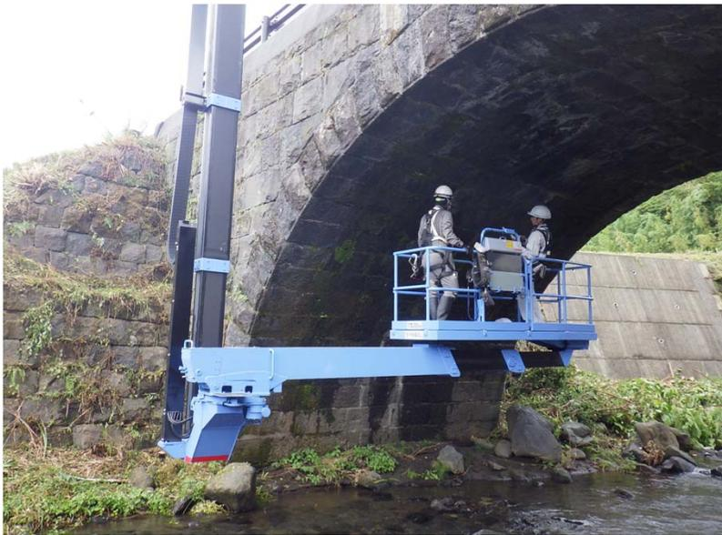
写13 橋梁点検車による作業状況
