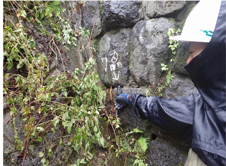
写20 石材の隙間の計測
