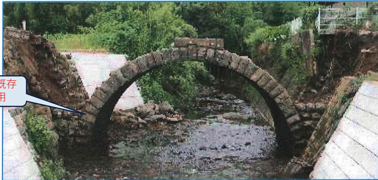
写5 壁石および中詰材を撤去し輪石のみの状況
