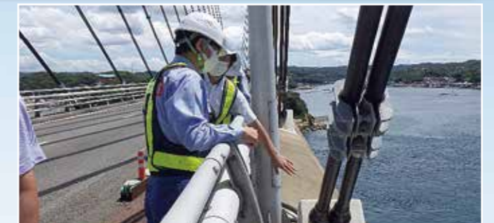
修繕代行橋梁の現地調査
