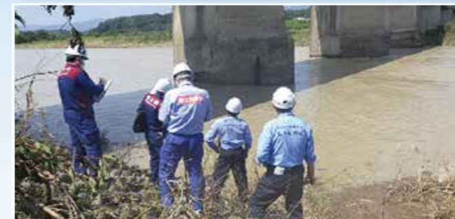
橋梁変状の現地調査
