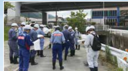
溝橋のひび割れ調査
