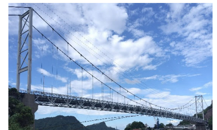
修繕代行：槌島大橋(熊本県 上天草市)
