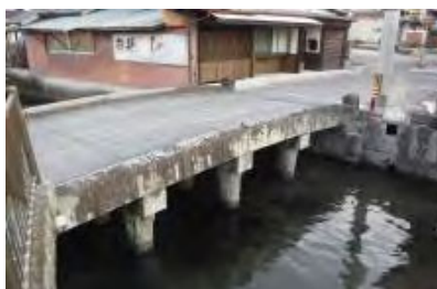
石桁橋：中の橋（佐賀市）
