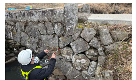
道路橋石橋の現地計測
