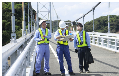
直轄診断：槌島大橋(熊本県 上天草市)
