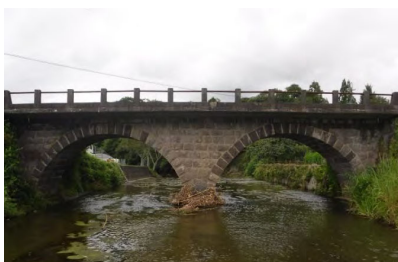
石造アーチ橋：久保橋（臼杵市）
