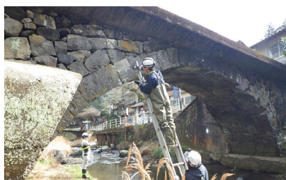
道路橋石橋の現地計測
