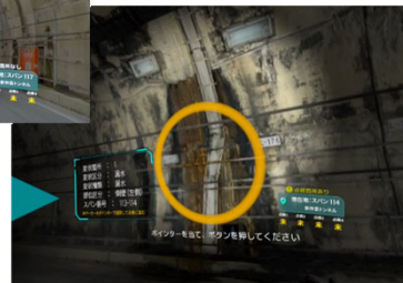
道路トンネル点検VRモデル
