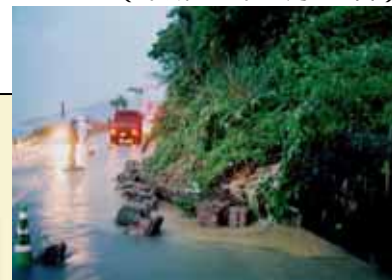
土砂災害による通行規制状況 (平成12年6月20日)
