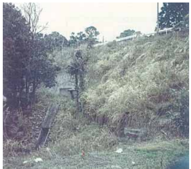
防災点検での対策必要箇所（松浦市今福町） 地すべりの末端部に位置しているため擁壁自体にクラック等の被害が発生。
