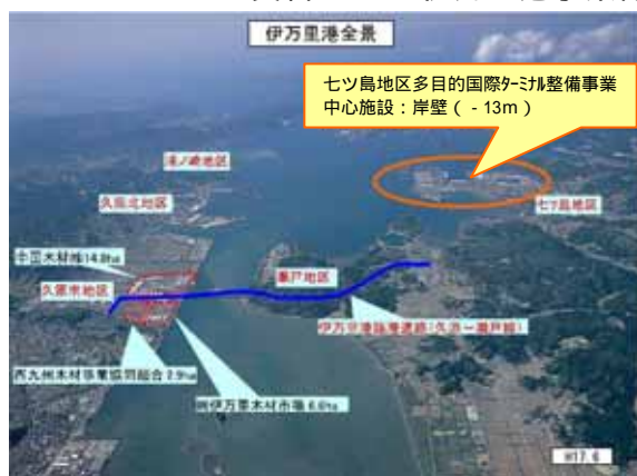
資料：伊万里港七ツ島地区多目的国際ターミナル整備事業再評価資料 七ツ島地区の岸壁整備状況
