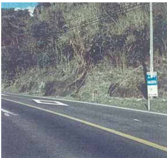
防災点検での対策必要箇所（松浦市調川町） 平尾第一地すべり付近に位置。この付近では平成元年度に斜面崩壊が発生し、国道に流下する道路災害が発生。
