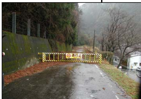
②(県)北方高千穂線通行止め状況
