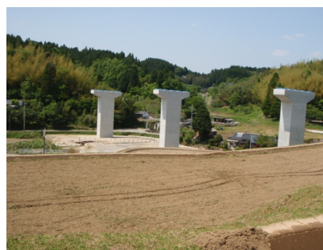
▲小池IC～北中島IC間 北中島橋
