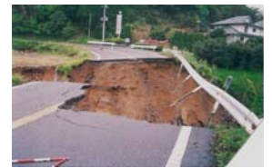
▲災害発生状況(国道 445 号: 御船町 滝尾)(平成 7 年発生)
