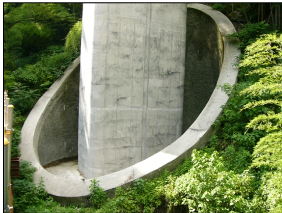
▲矢形川橋 P1橋脚
