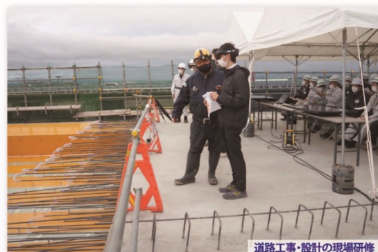
道路工事・設計の現場研修
