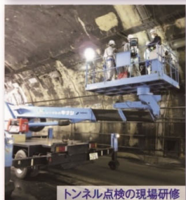
トンネル点検の現場研修
