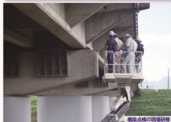
橋梁点検の現場研修
