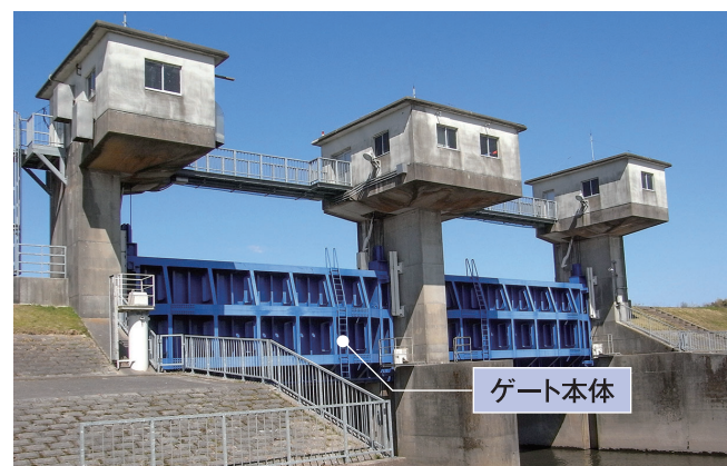
※ゲート設備構成 = ゲート本体 + 開閉装置 + 操作制御装置
