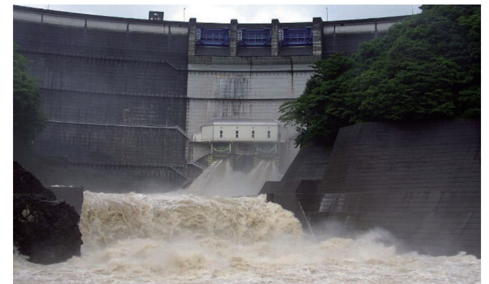
洪水時のダム放流設備からの放流状況
