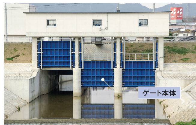
※ゲート設備構成 = ゲート本体 + 開閉装置 + 操作制御装置
