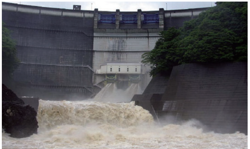
洪水時のダム放流設備からの放流状況
