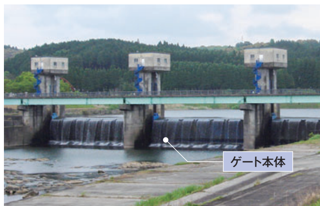
せき 堰 河川用ゲート設備
