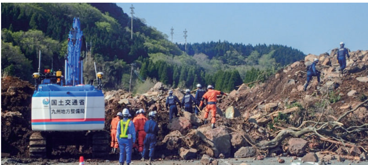
遠隔操縦の重機が搜索を支援(南阿蘇村)
