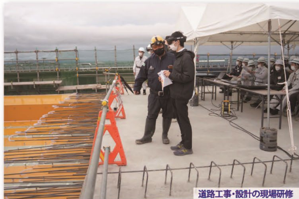
道路工事・設計の現場研修
