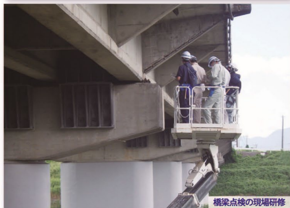
橋梁点検の現場研修
