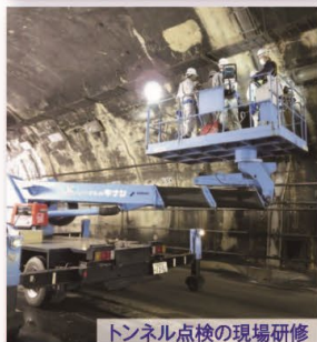
トンネル点検の現場研修
