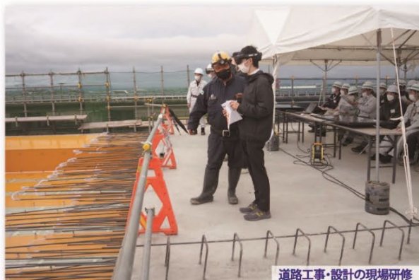
道路工事・設計の現場研修
