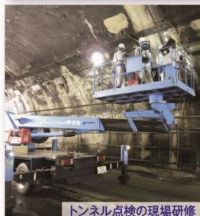
トンネル点検の現場研修
