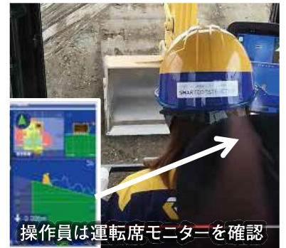
3次元設計データを建設機械に取り込み 目印(丁張り)無しで施工可能
