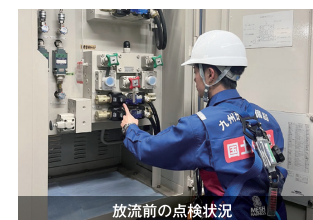
放流前の点検状況
