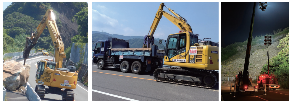
遠隔操作で巨大な落石を小割
