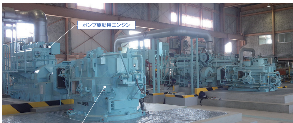
据付施工中の主ポンプ設備（口径2400mm）
