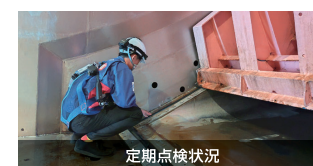
定期点検状況
