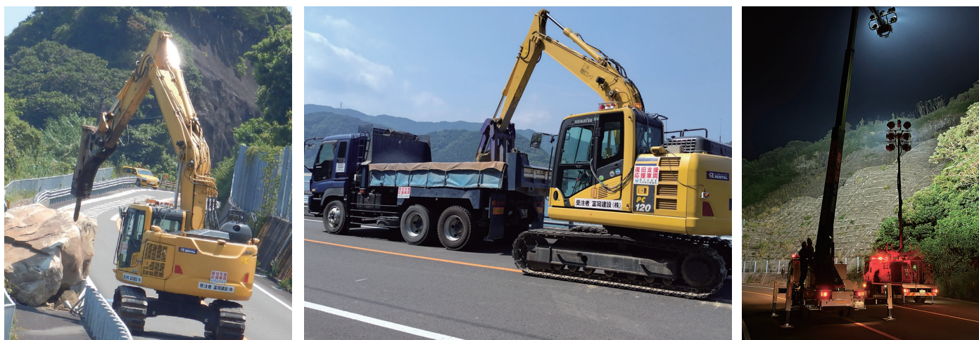
遠隔操作で巨大な落石を小割
