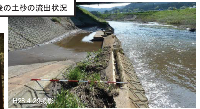
地震後の土砂の流出状況
