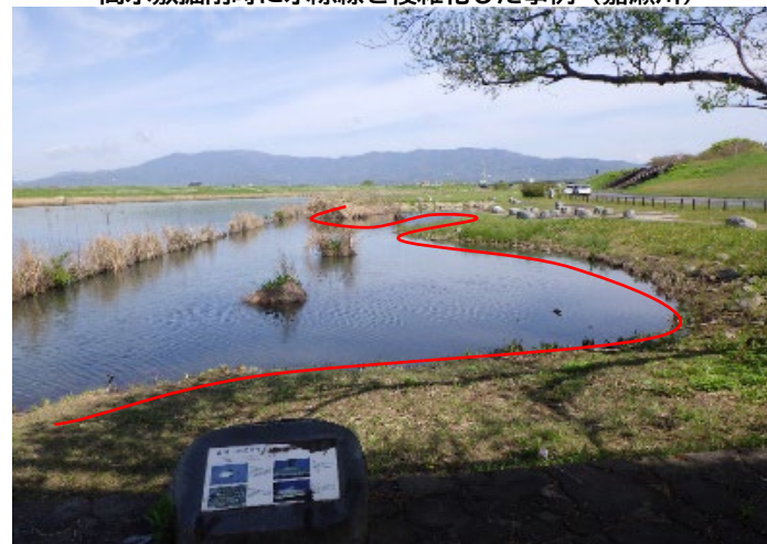
高水敷掘削時に水際線を複雑化した事例（嘉瀬川）
