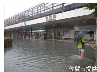
佐賀駅前における浸水状況 令和元年8月洪水
