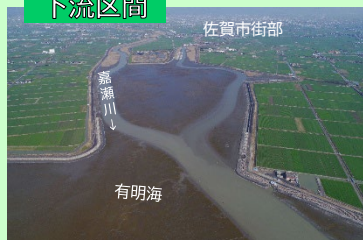
嘉瀬川下流区間の空中写真
