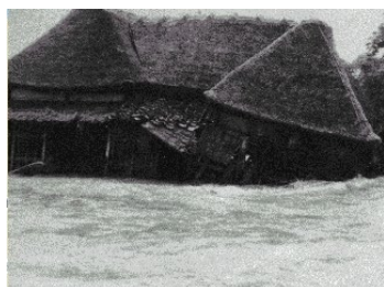
三日月町道辺地先付近濁流により倒壊寸前の家屋
