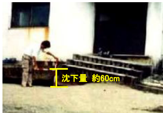
写真 2.2.7 白石町での地盤沈下状況
