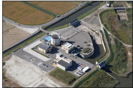
写真 2.1.4 巨勢川ポンプ場
