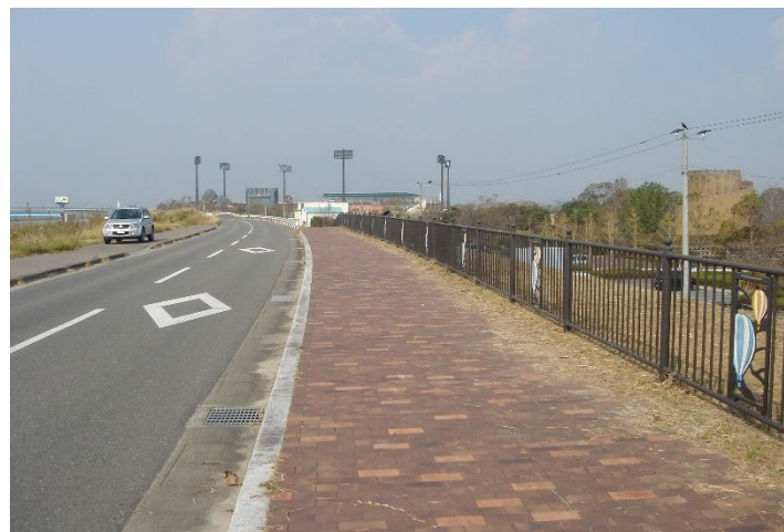
写真 2.3.18 佐賀環状自転車道
