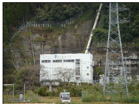
写真 2.2.5 鮎の瀬発電所
