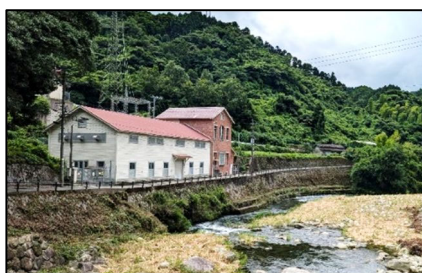
写真 1.3.1 川上川第二発電所
