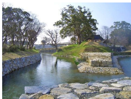
写真 2.3.37 石井樋公園周辺の風景
