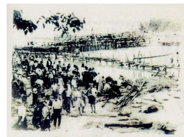
↑ 決壊箇所の復旧工事
