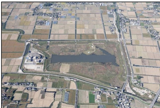
写真 2.1.3 巨勢川調整池
