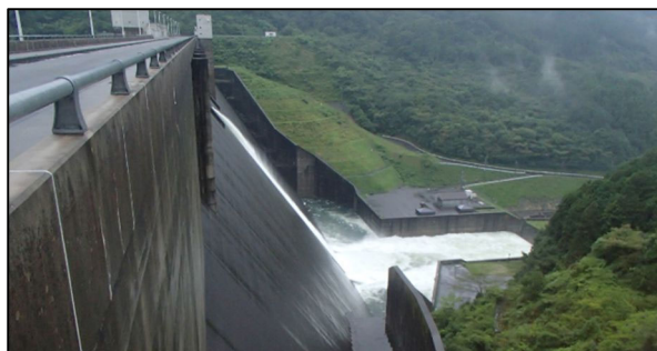
写真 1.2.4 洪水調節中の嘉瀬川ダム
