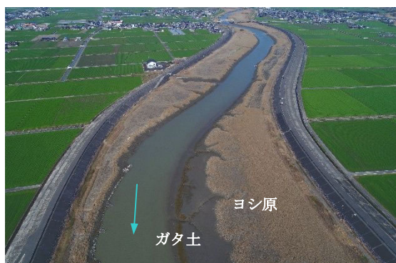
写真 2.1.5 ガタ土の堆積状況（佐賀市）
