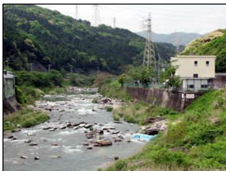
写真 2.2.4 川上川第五発電所
