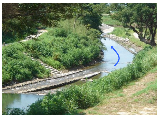
写真 2.3.16 二の井手堰の魚道
