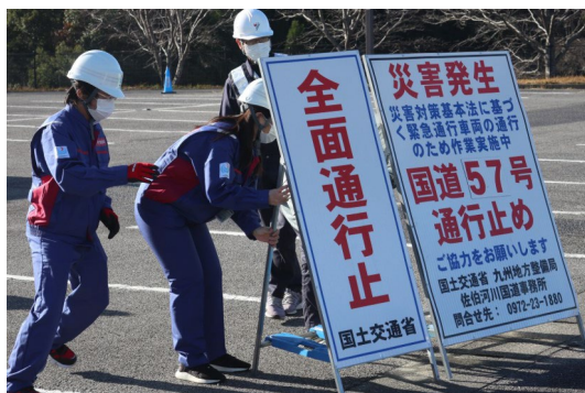
全面通行止め看板設置状況
