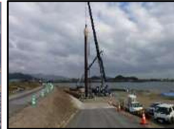
沈下防止のための矢板打設
