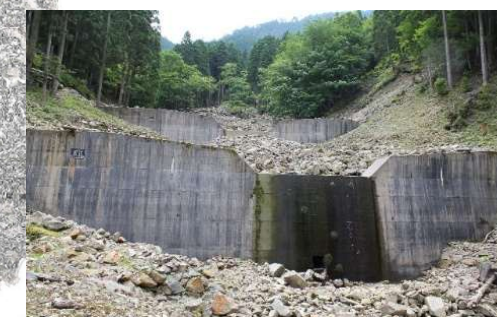
土砂を補足した治山ダム
