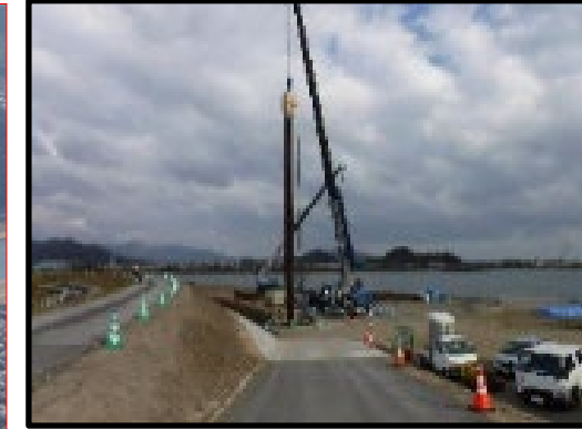
沈下防止のための矢板打設
