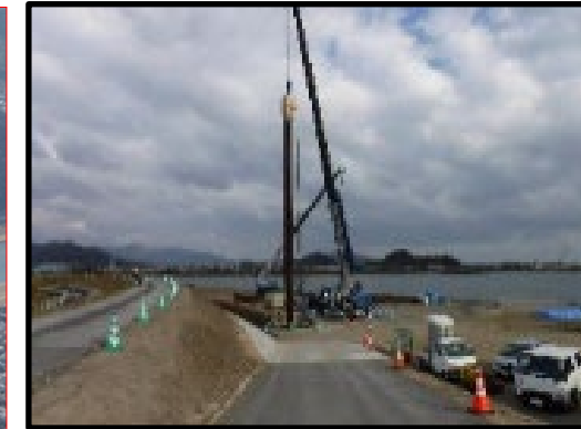
沈下防止のための矢板打設
