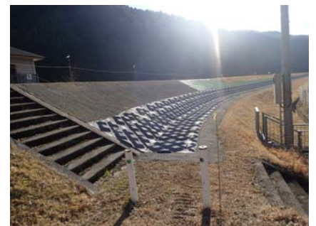
堤防裏法尻補強(久留須川 深瀬地区)
