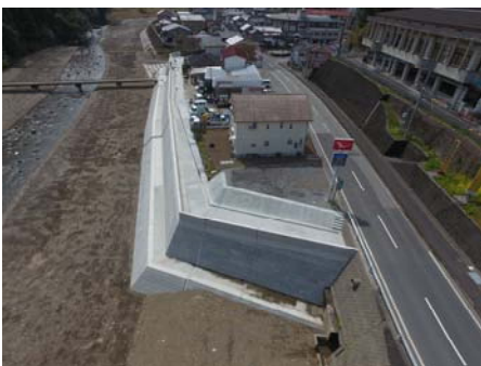
堤防整備(番匠川 波寄地区)
