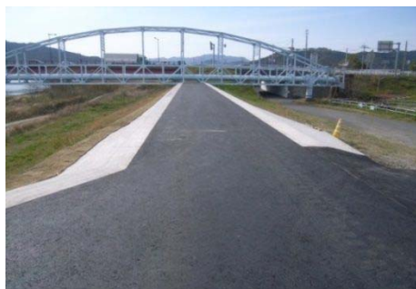
堤防天端の保護(番匠川 女島地区)
