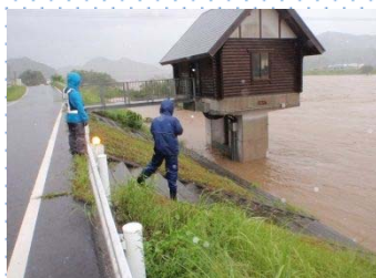
洪水時の現地確認状況① (H28.9月台風16号)
