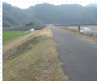
堤防への土砂の備蓄 （番匠川尾岩地区）
