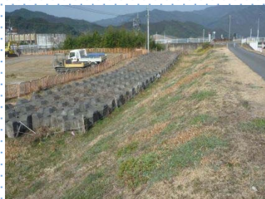
根固めブロックの備蓄 （番匠川堤内地区）
