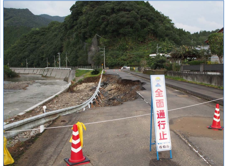
市道 備後尺間線（佐伯市弥生大字尺間） 平成29年9月25日時点
