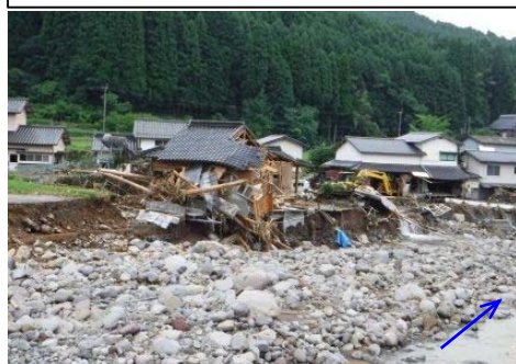
洪水により家が倒壊
