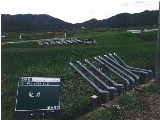
柏江地区排水ポンプ設置状況
