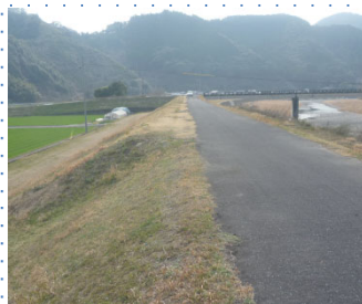
堤防への土砂の備蓄 (番匠川尾岩地区)
