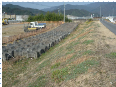
根固めブロックの備蓄 (番匠川門田地区)
