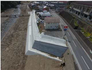
堤防整備(番匠川 波寄地区)
