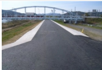
堤防天端の保護(番匠川 女島地区)
