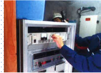
日頃からの水位観測所の点検 (佐伯河川国道事務所資料)
