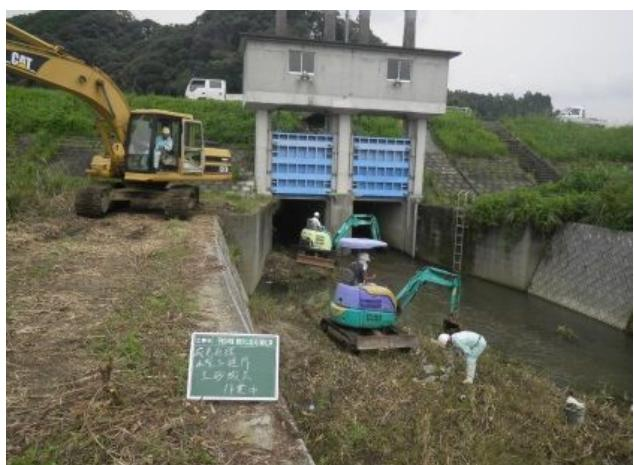
写真 4-3-4 堆積土砂の撤去
