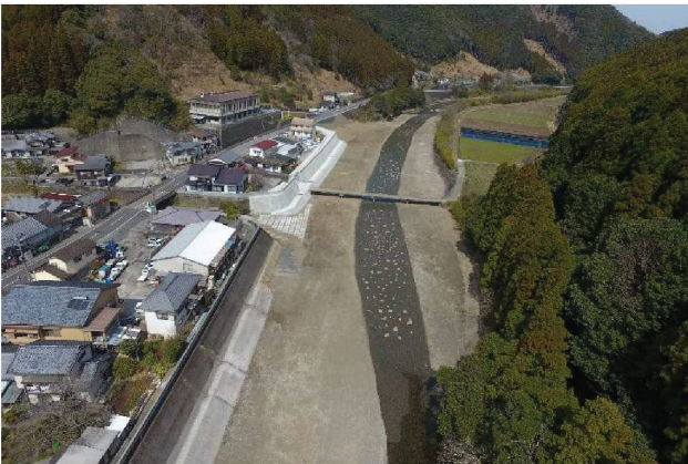
写真 1-2-3 波寄地区堤防整備
