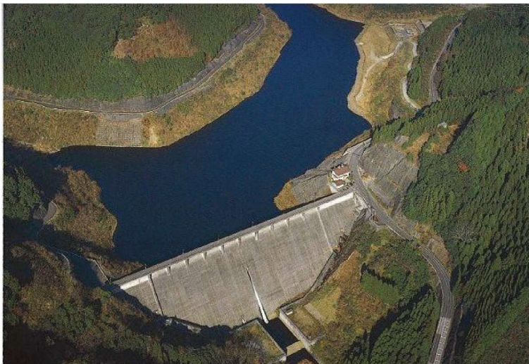
写真1-2-6 床木ダム(大分県)
