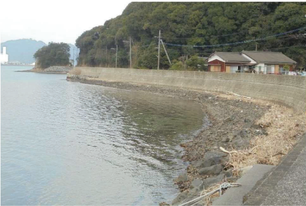
写真 1-2-1 灘地区堤防整備
