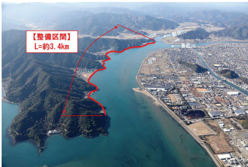
写真 1-2-8 灘地区堤防整備
