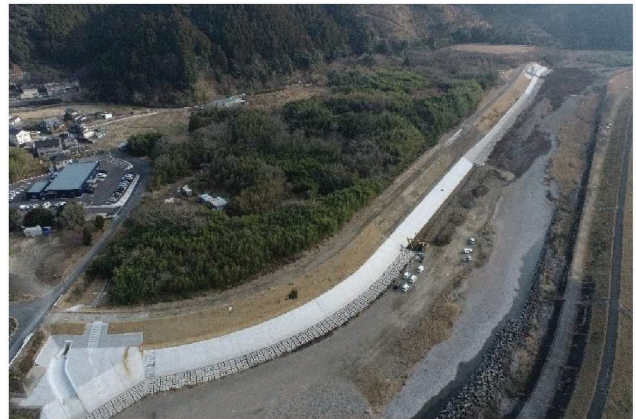
写真 1-2-4 蕨野地区堤防整備
