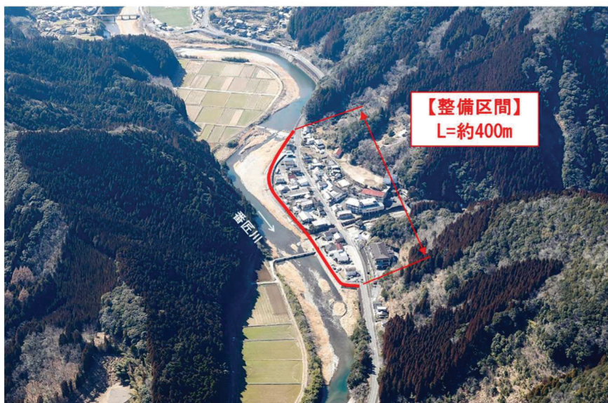
写真 1-2-9 波寄地区堤防整備
