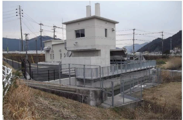
写真 1-2-2 蛇崎排水機場整備
