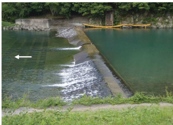
写真 2-3-16 常盤井堰 (番匠川 15.1k 付近)
