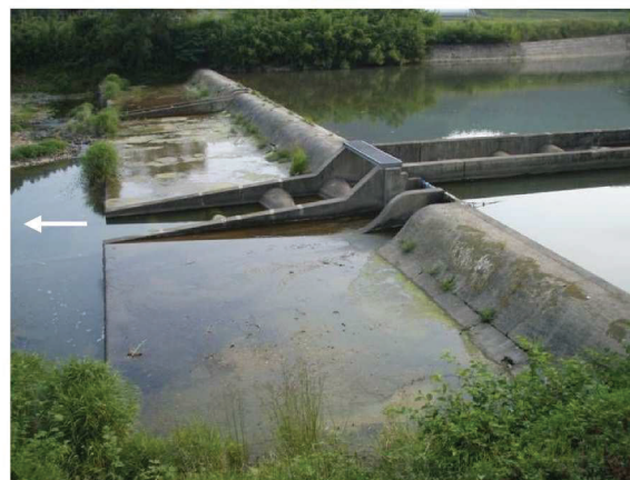
写真 2-3-17 浦木井堰 (久留須川 5.2k 付近)
