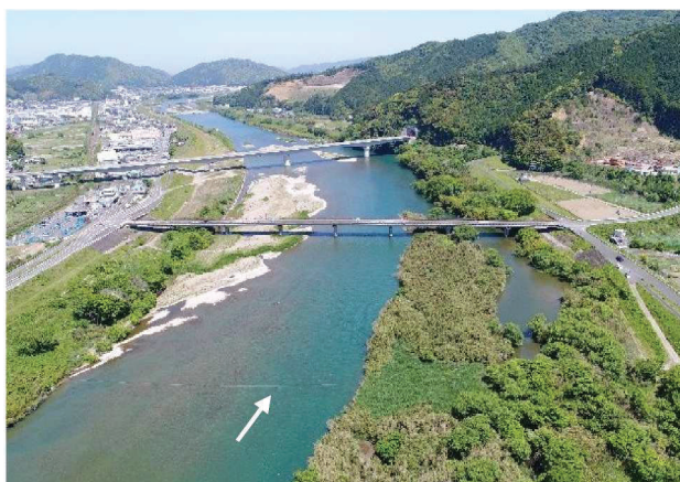
写真4-2-4 檜野橋付近（番匠川8k付近）
