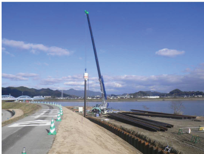
写真 4 - 2 - 2 耐震対策工事状況
