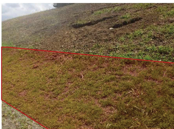
写真4-3-7 被害箇所の法面補修状況（赤枠）
