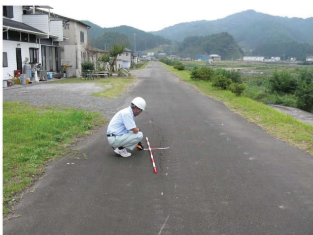
写真 4-3-3 河川管理施設の点検 洪水、高潮等の発生時に治水機能が発揮されるように、平常時から巡視や点検を行っています。
