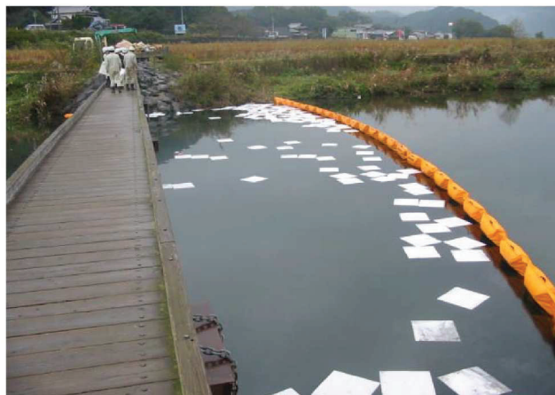
写真 4-3-20 水質事故発生時の対応 水質事故発生時には、適切な箇所ではオイルフェンスや吸着マット等を設置し、下流への被害の拡大を防止します。
