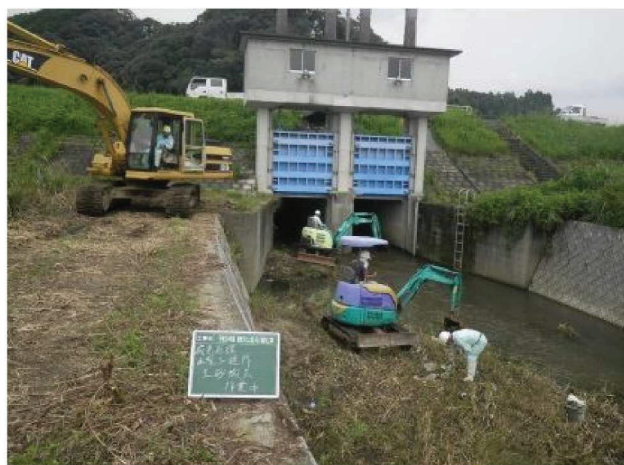
写真 4-3-4 堆積土砂の撤去 河川管理施設の機能の維持のため、堆積土砂の撤去を行います。
