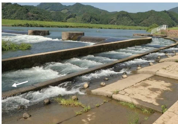
写真 4-2-6 魚道が機能している堰（小田井堰）
