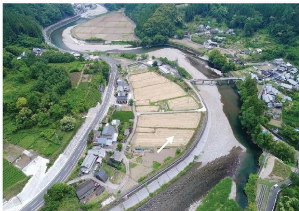
写真4-2-3 原橋付近（番匠川18k付近）
