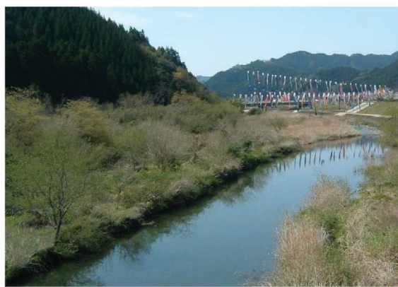
写真4-3-11 河道内の樹木 (井崎川井崎地区)
