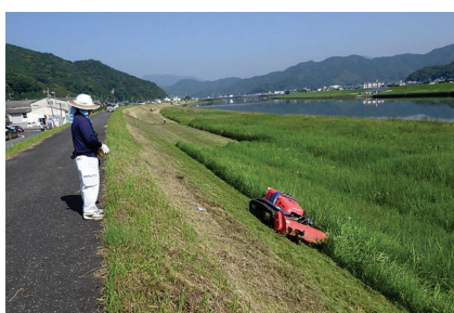
堤防斜面の除草状況
