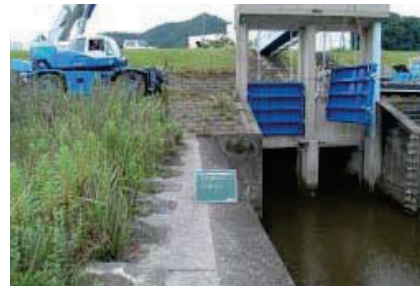
門扉の補修状況
