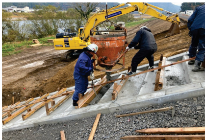
階段の補修状況
