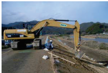
堤防斜面の補修状況
