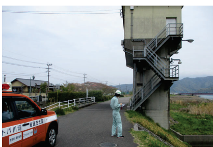
河川巡視の状況
