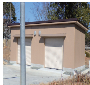
防災用備蓄倉庫
