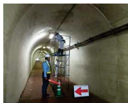
足場を使用したトンネル点検状況
