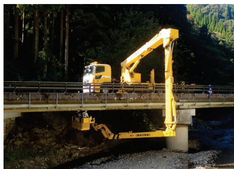
橋梁点検車による点検状況
