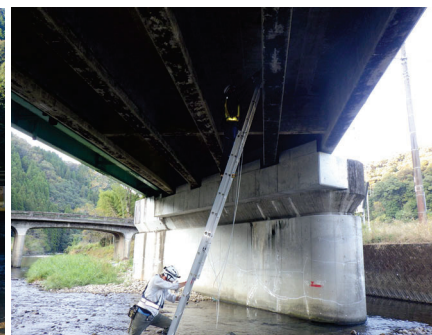
ハシゴによる橋梁点検状況
