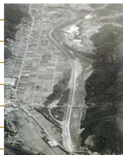
●井崎川捷水路工事／昭和54年度
