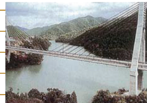
●一般国道326号頃んか大橋(施工後)／平成5年度
