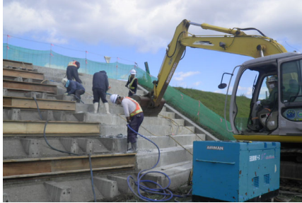
階段の補修状況
