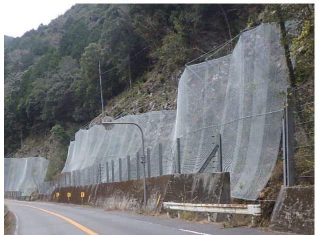
ポケット式落石防護柵
