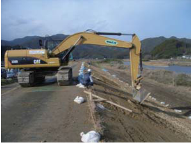
堤防斜面の補修状況
