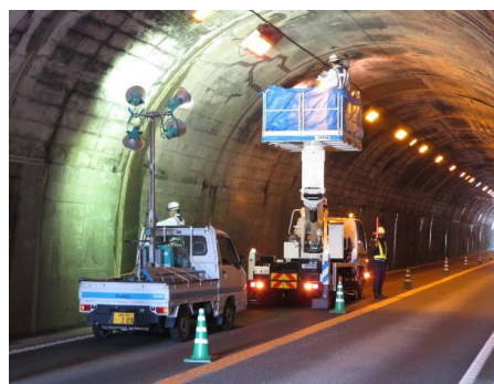
高所作業車によるトンネル点検状況
