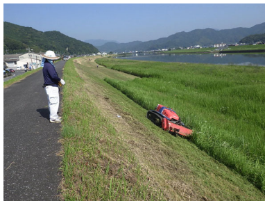
堤防斜面の除草状況
