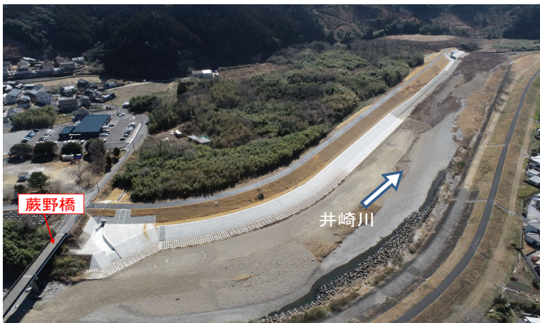
【弥生井崎地区付近の様子(令和3年度 完成)】
