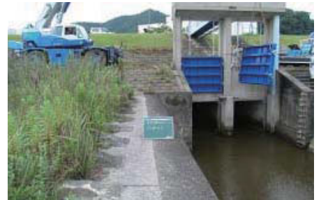
門扉の補修状況
