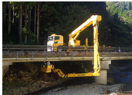
橋梁点検車による点検状況
