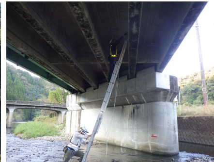
ハシゴによる橋梁点検状況
