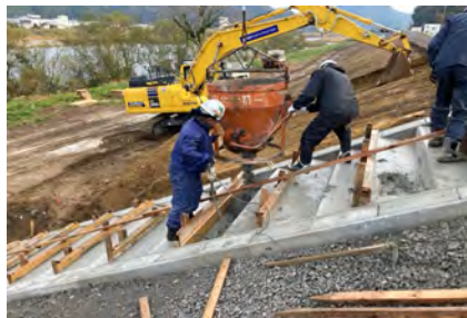
階段の補修状況
