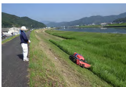
堤防斜面の除草状況
