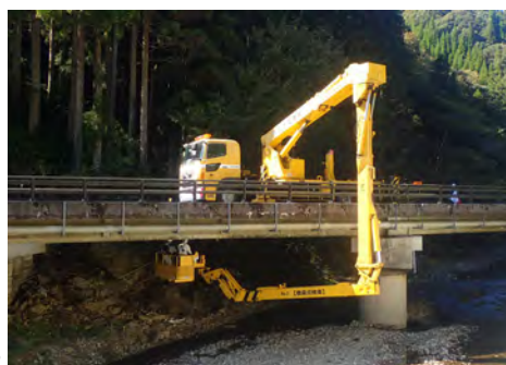
橋梁点検車による点検状況
