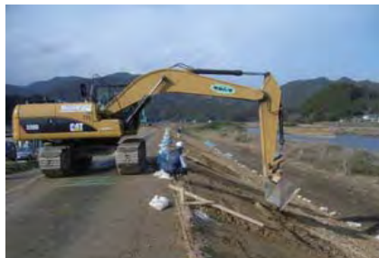
堤防斜面の補修状況
