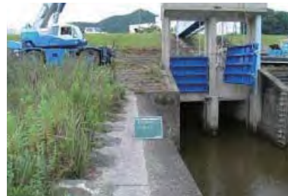
門扉の補修状況
