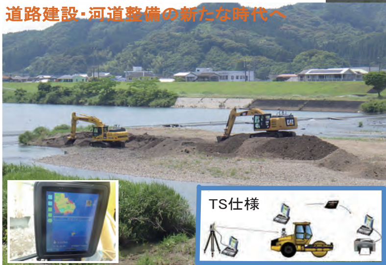
ICT建設機械による施工
