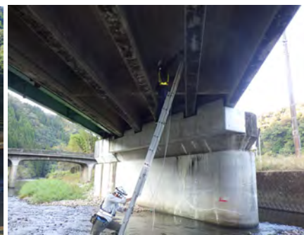
ハシゴによる橋梁点検状況
