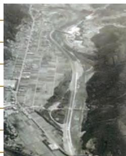
●井崎川捷水路工事/昭和54年度
