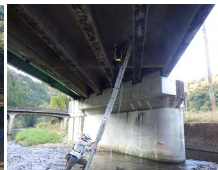
ハンゴによる橋梁点検状況
