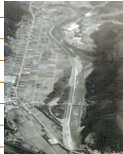
●井崎川捷水路工事/昭和54年度
