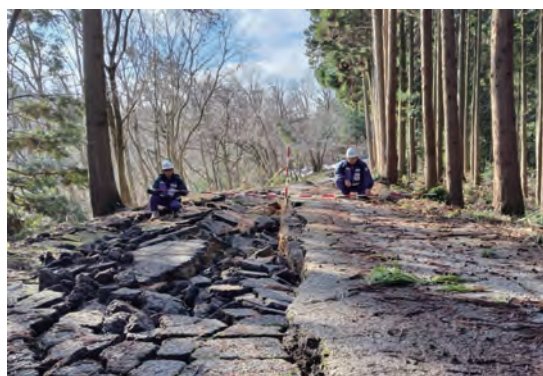
調査状況(石川県輪島市)
