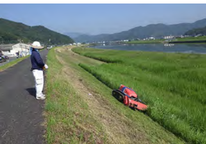
堤防斜面の除草状況
