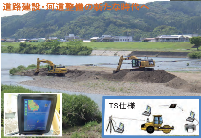
ICT建設機械による施工
