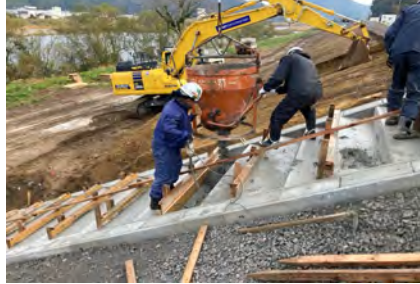
階段の補修状況
