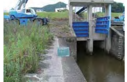
門扉の補修状況
