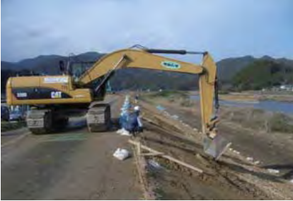
堤防斜面の補修状況
