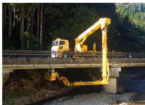
橋梁点検車による点検状況
