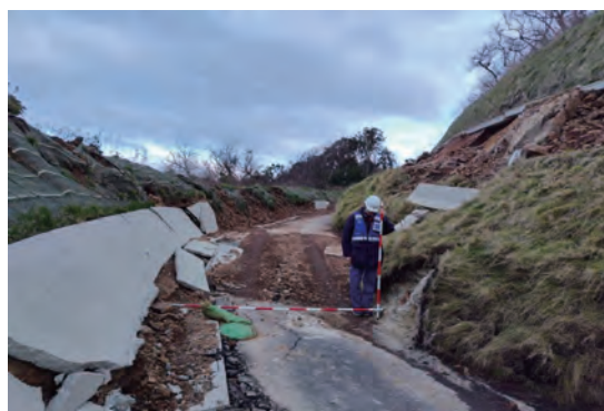
調査状況(石川県輪島市)
