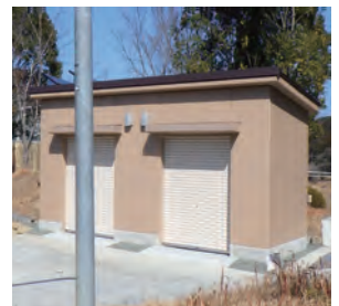
防災用備蓄倉庫
