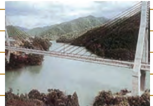
●一般国道326号唄げんか大橋(施工後)/平成5年度
