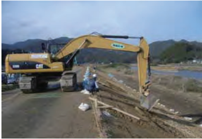
堤防斜面の補修状況
