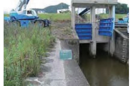
門扉の補修状況
