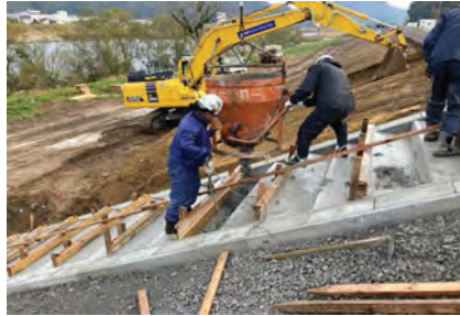
階段の補修状況
