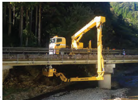
橋梁点検車による点検状況
