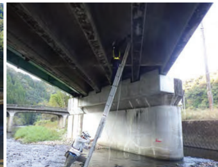
ハンゴによる橋梁点検状況
