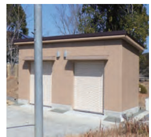
防災用備蓄倉庫
