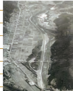
●井崎川捷水路工事/昭和54年度
