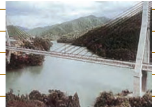
●一般国道326号唄んか大橋(施工後)/平成5年度
