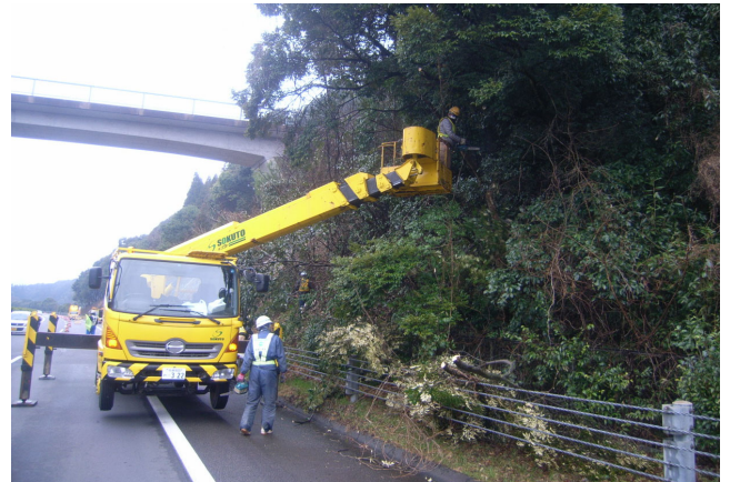
＜樹木伐採作業＞
