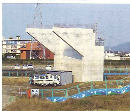
完成した伊万里側の橋台
