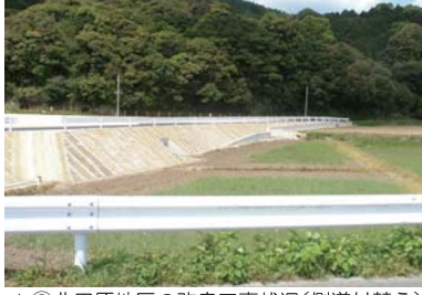
▲⑧北田原地区の改良工事状況(側道付替え)
