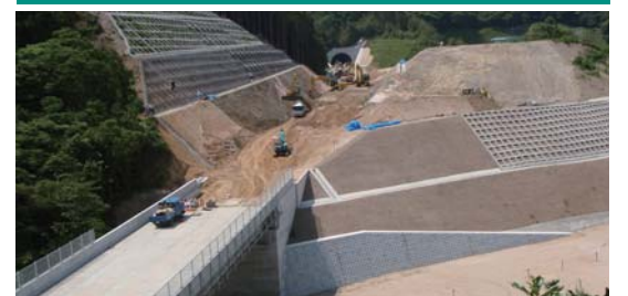
▲②鹿家包石地区の改良工事状況
