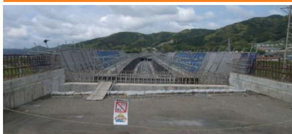
▲④松浦川大橋整備状況
