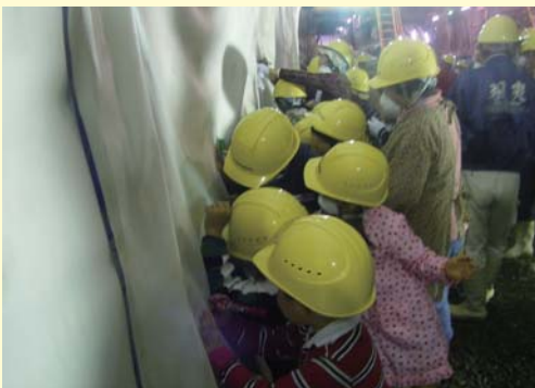
トンネル内の防水シートに絵を描きました
