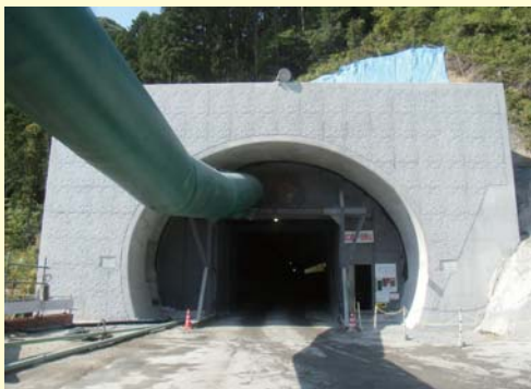
山彦トンネルの抗門(トンネルの顔)
