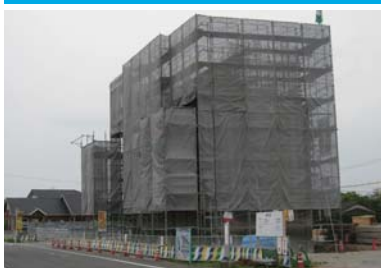
▲⑦佐代川橋整備状況
