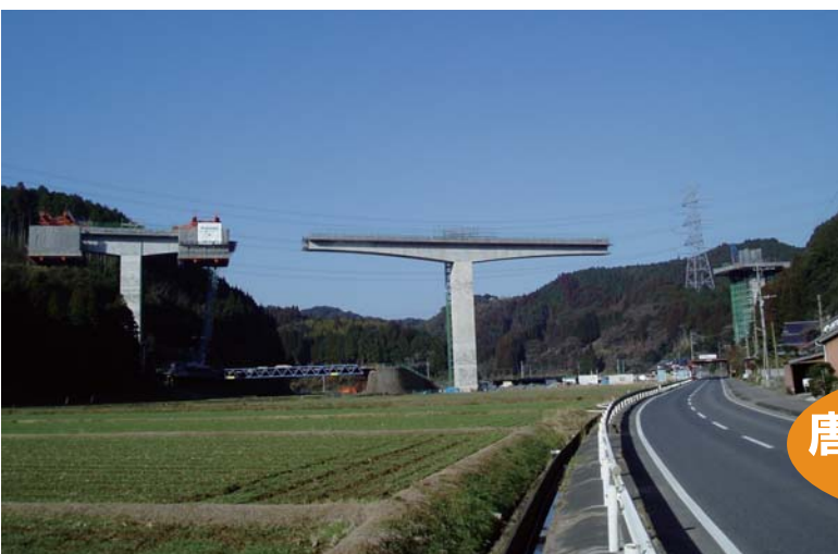
▲工事中の行合野大橋
