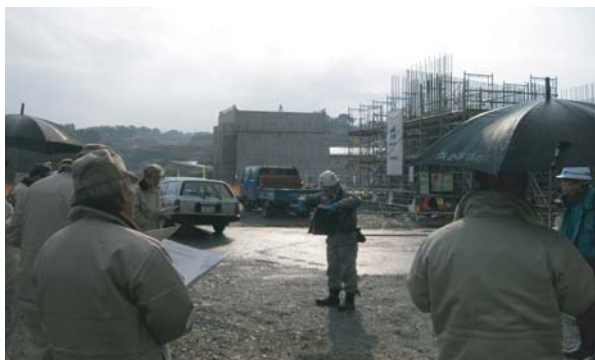
▲佐代川橋下部工の現場視察
