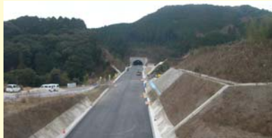
4 国道 202 号から千々賀地区を望む
