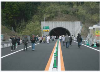
▲養母田トンネルを歩いて通過
