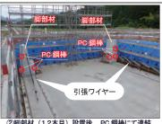
②脚部材(1,2本目)設置後、PC 鋼棒にて連結 脚部材背面を引張ワイヤーにて固定
