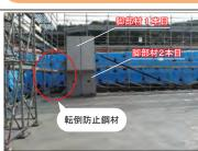
①脚部材前面に転倒防止鋼材を設置 \_\_\_\_\_(1本目のみ)
