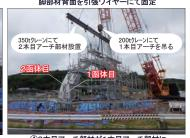
④2本目アーチ部材が1本目アーチ部材に 寄りかかる重量低減のため、1本目アーチ部材を 200t 吊クローラクレーンにて吊ることによる転倒防』
